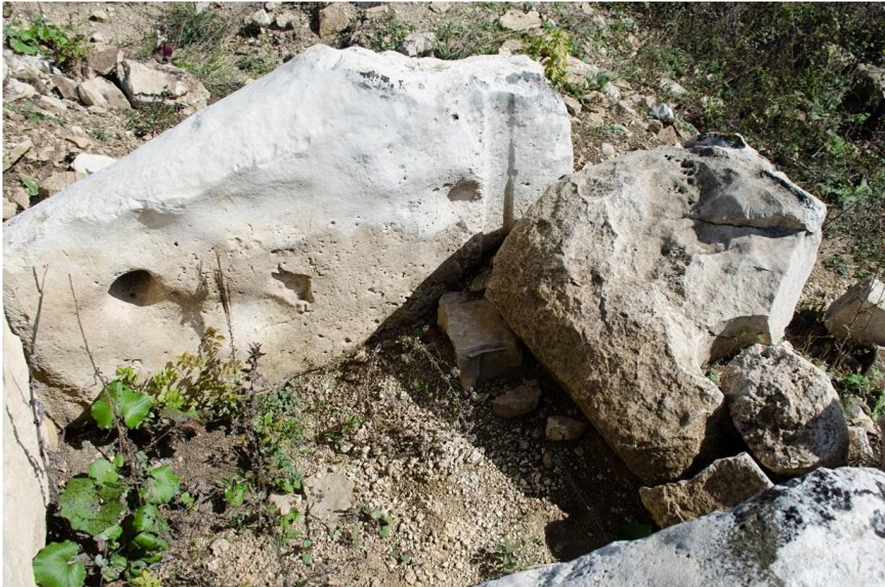
Загадочное отверстие в боковой плите
