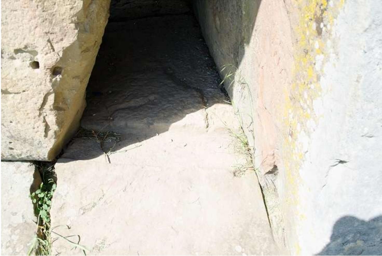
Кроме того, местами на поверхности плит наблюдается образование, напоминающее... штукатурку. Как если бы сооружение было после постройки оштукатурено, а потом со временем покрытие кое-где отвалилось.
